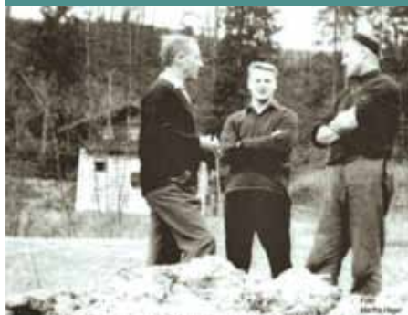
Zur ersten Aufgabe des neuen Vereins gehörte der Bau des Fußballplatzes 1965 - Gründungstmann Walther Thaler mit Franz Hager und Johann Ruggschädel beim Innegraben der Baustelle beim Inngrätz
