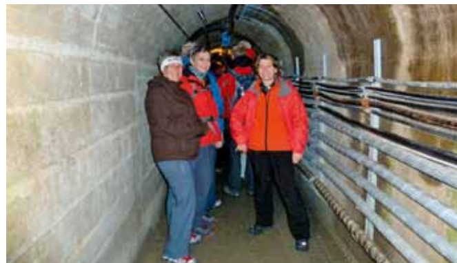
▲ Die Staumauerführung bringt uns tief in das Innere der Mooser-Sperre.
