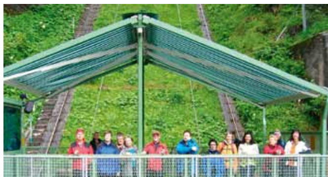
▲ Mit dem Schrägaufzug auf dem Weg zur Mooser-Sperre.
