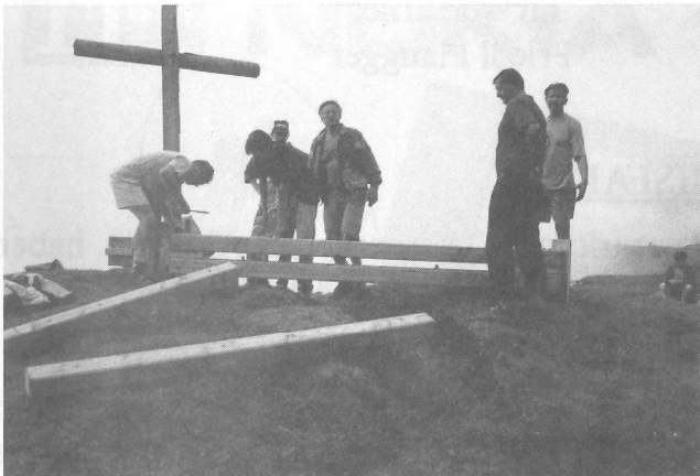
Im Hintergrund steht noch das alte Kreuz .... doch am Zusammenbau des neuen wird bereits eifrig gearbeitet
