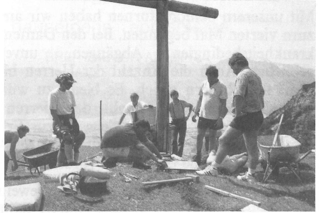
Das neue Fundament ist bereits fast fertig und der Blitzableiter wird installiert ..... und jeder paßt auf, daß alles richtig gemacht wird
